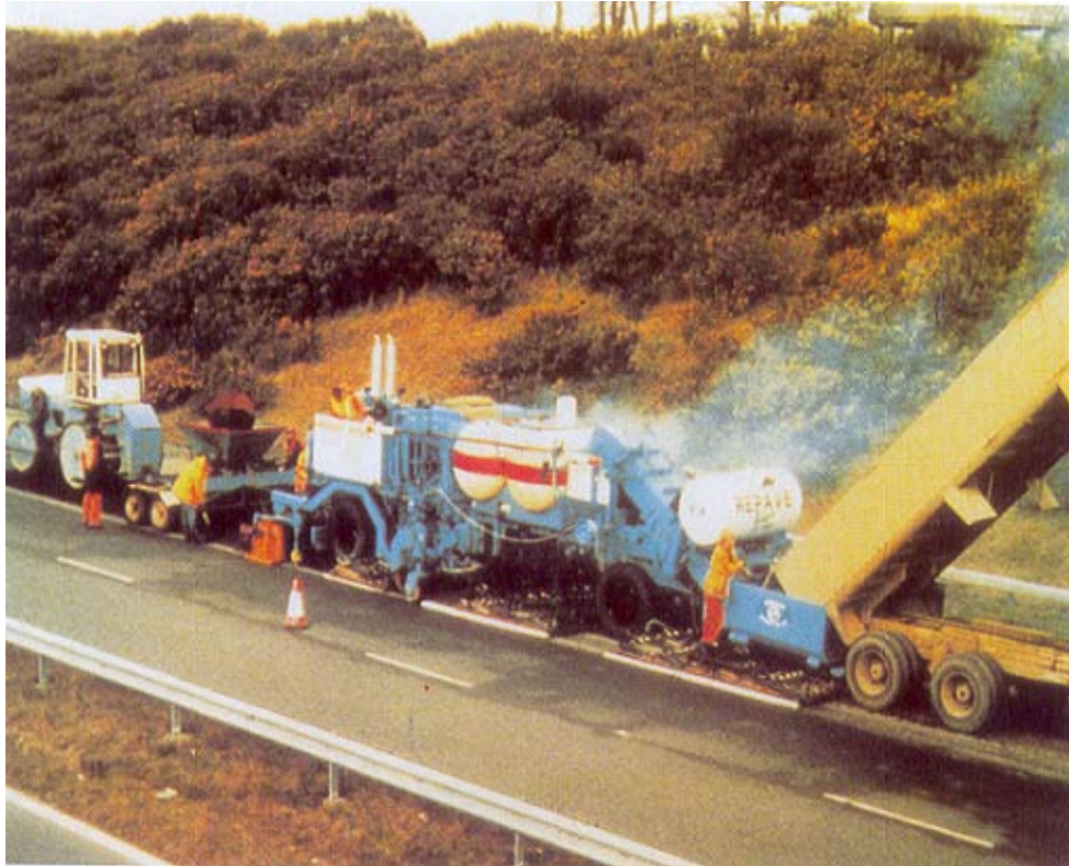
Hình 9.6. Quá trình rải lại mặt đường
