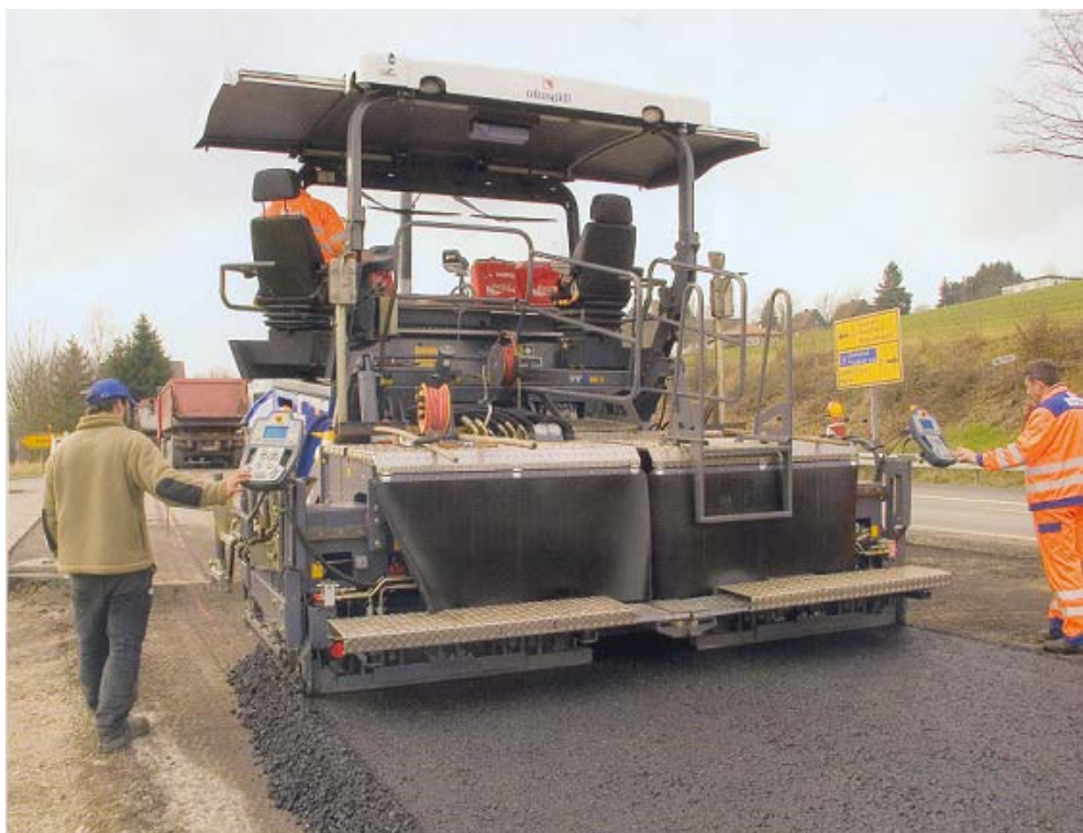
Hình 10.1. Máy rải bê tông asphalt
